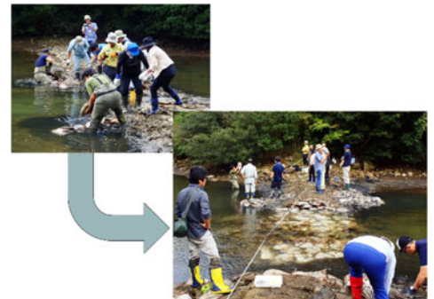
和具地区での土嚢撤去作業
